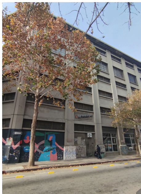
Antiguo edificio de la Fábrica Alpargatas (2024). Foto: Joaquina González.
