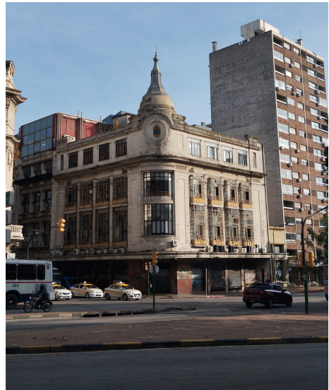
Antiguo edificio de la Tienda Introzzi (2024). Foto: Joaquina González.
