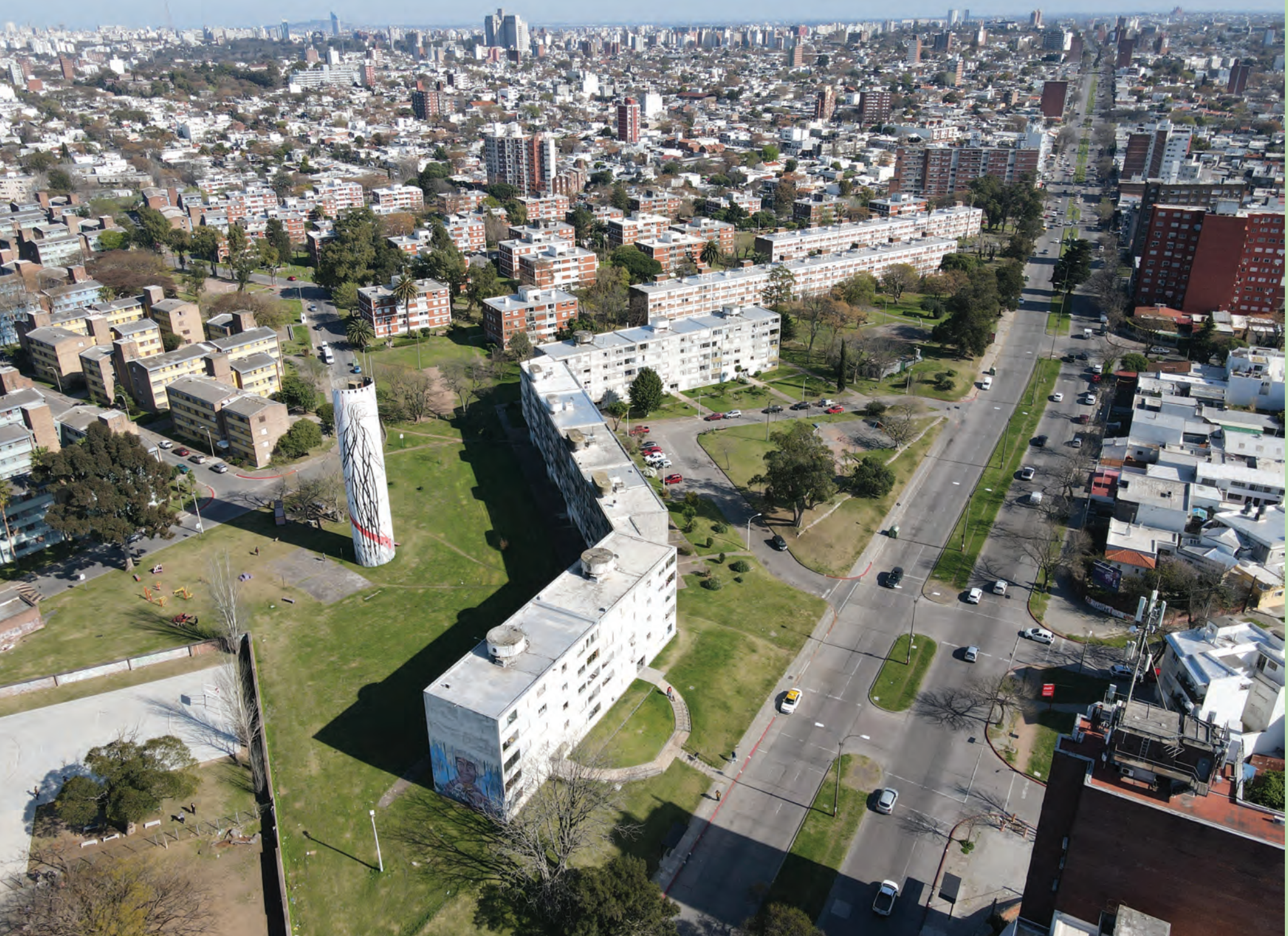
Vista aérea tomada a vuelo de dron de la Unidad de Habitación 1, Buceo. Fotografía de Martín Cajade, 2022.
