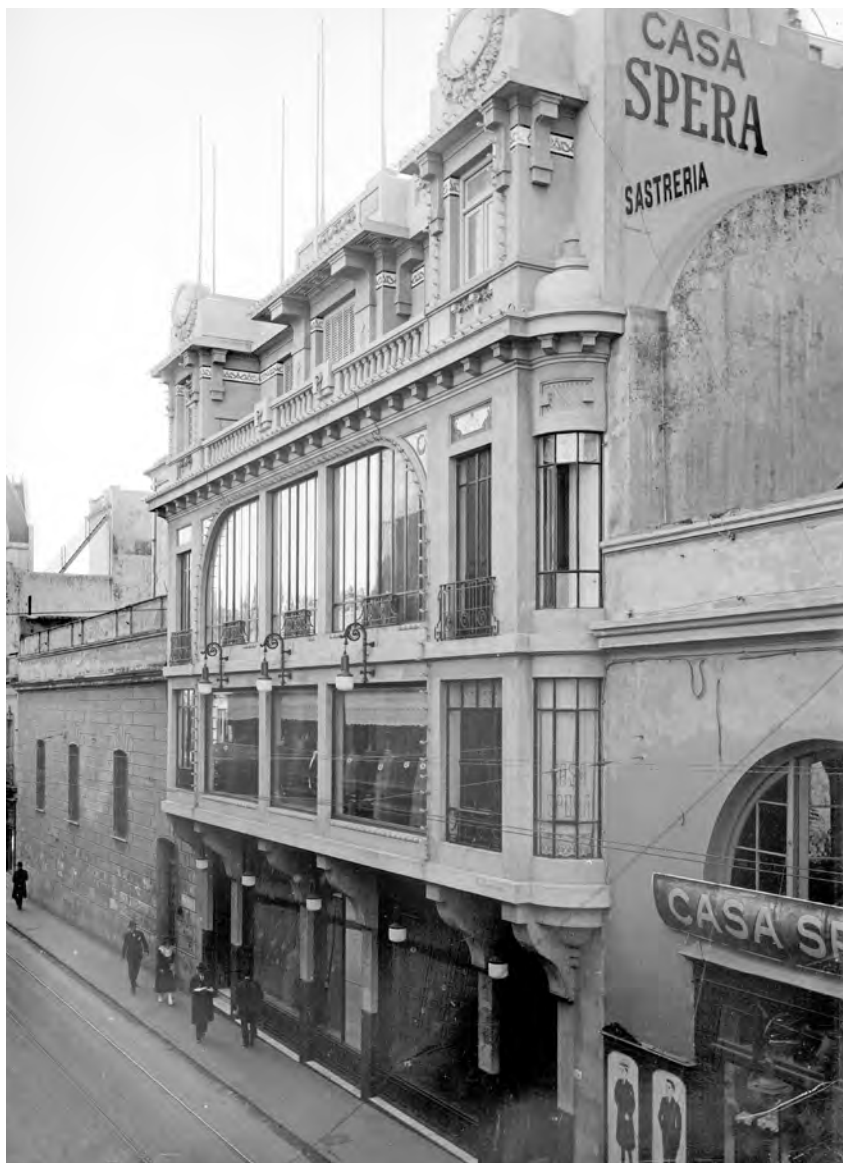
Casa Spera, lindera a la catedral de Montevideo (demolida) en 1918. CdF, IM. Foto 01981FMHGE, sin datos de autoría.
