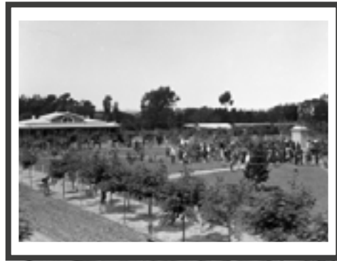
ESTACION DE COLON, 1900 APROX.
