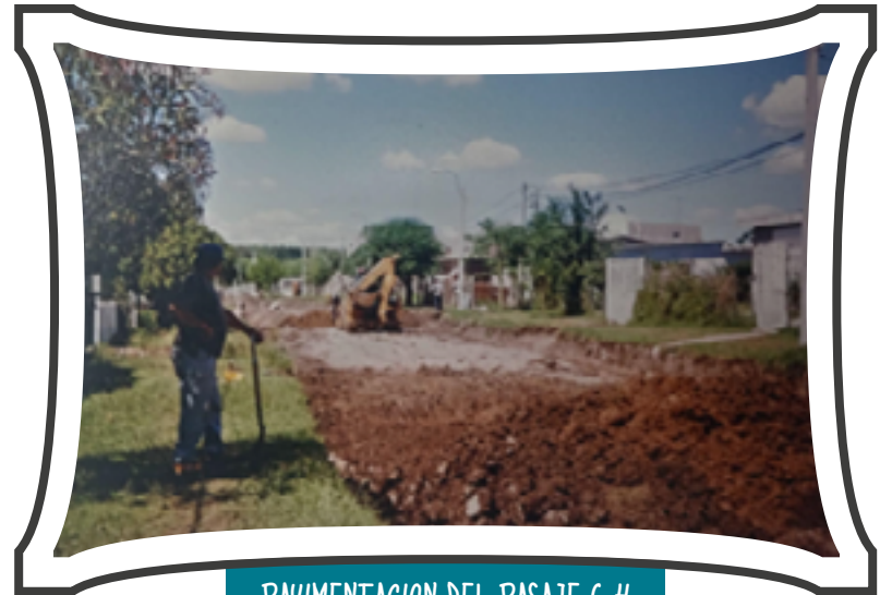
PAVIMENTACION DEL PASAJE 6 # ENTRE ALBENIZ Y PASAJE I
