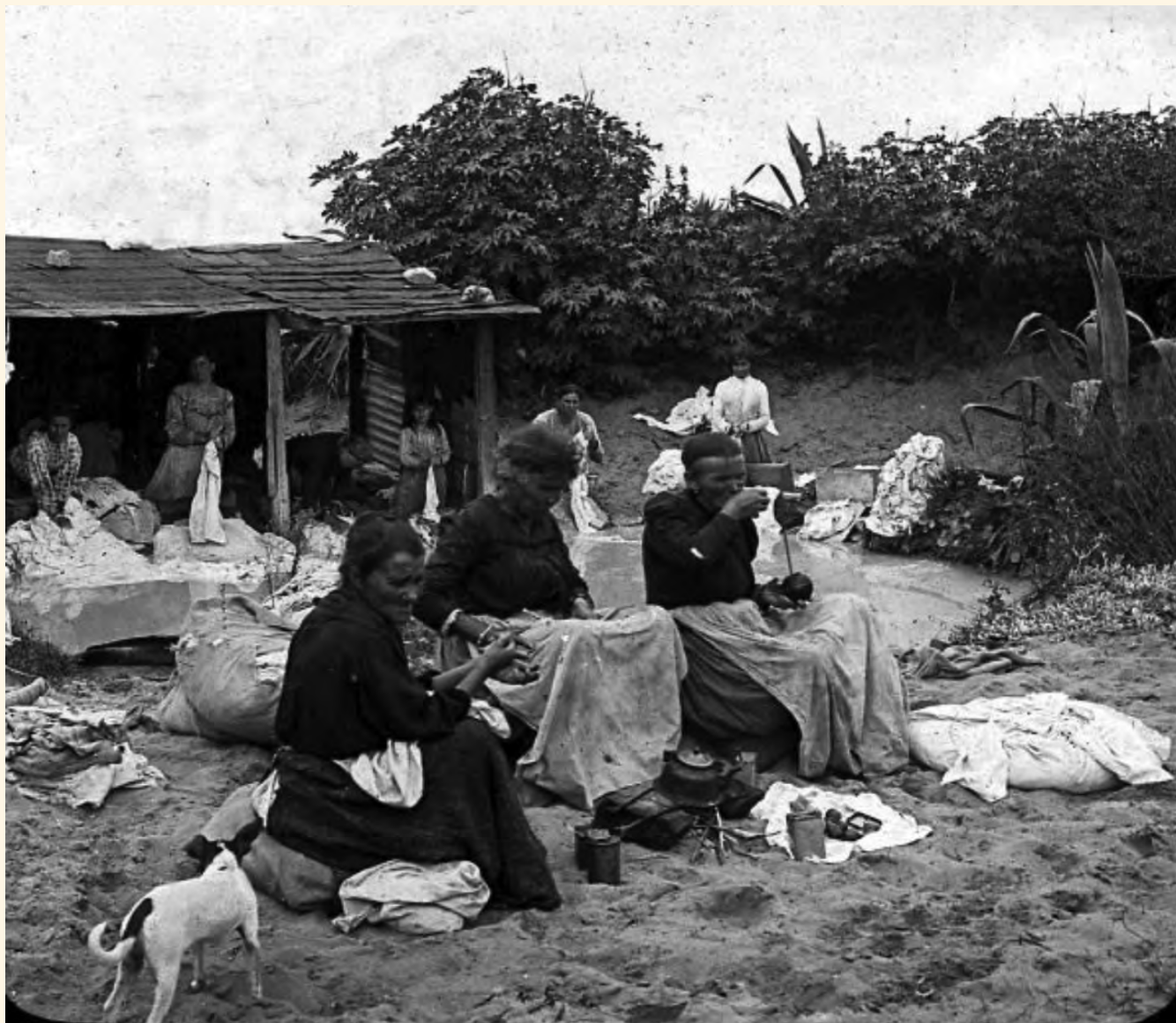
Lavanderas en el arroyo De los Pocitos. C18f175. Tomada de https://picryl.com/amp/media/c18f175lavanderas-de-arroyo-de-los-pocitos-a2639d
