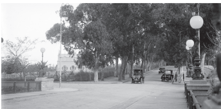
Puente de la Av. Buschental sobre el arroyo Miguelete, 1921. Centro de Fotografía de Montevideo
