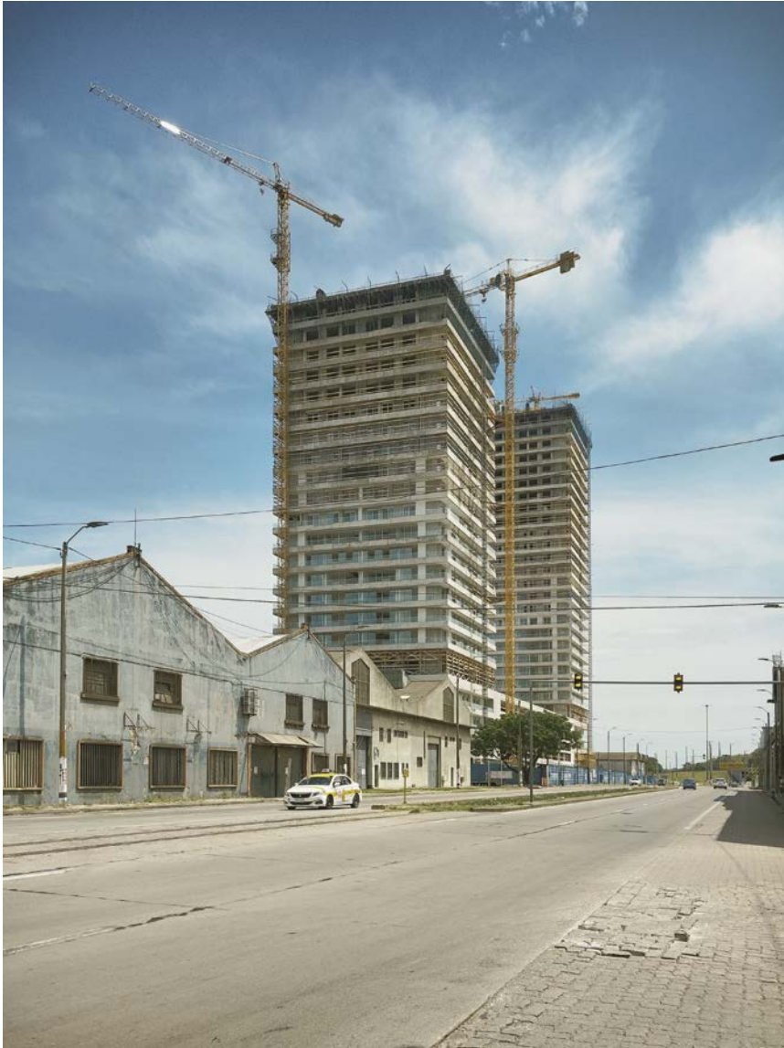
Torres en construcción, 2025. Fotografía de Santiago Medero.
