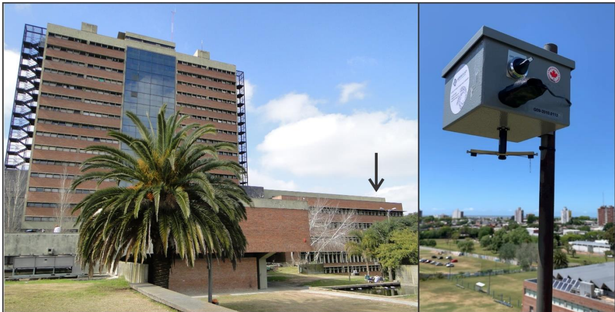
Muestreador aerobiológico GRIPST-2009 y su ubicación en la azotea de la Facultad de Ciencias (Malvín Norte).
