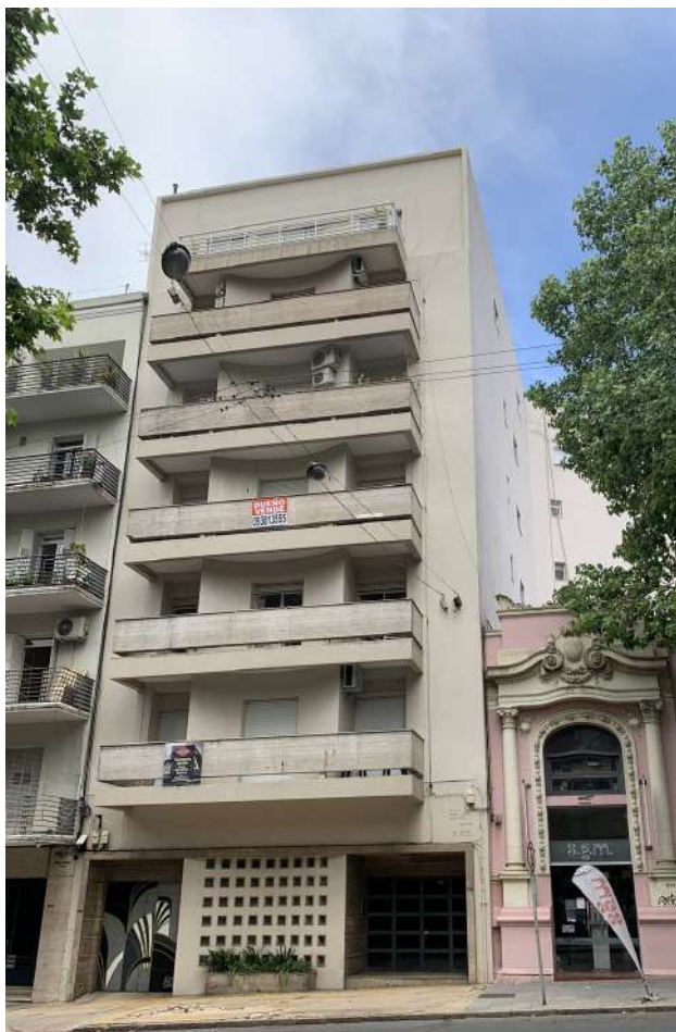
Fachada Bulevar España
