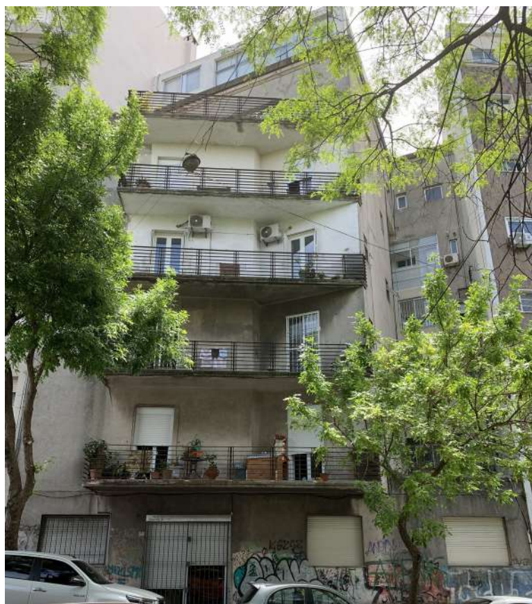
Fachada sobre la calle Durazno
