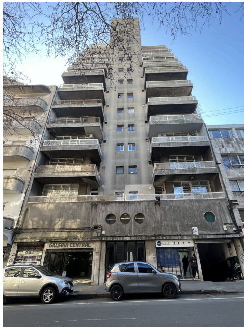
Edificio San José. San José 979. Arqs. Julio Etchebarne y Elías Ciurich, 1934-36.
